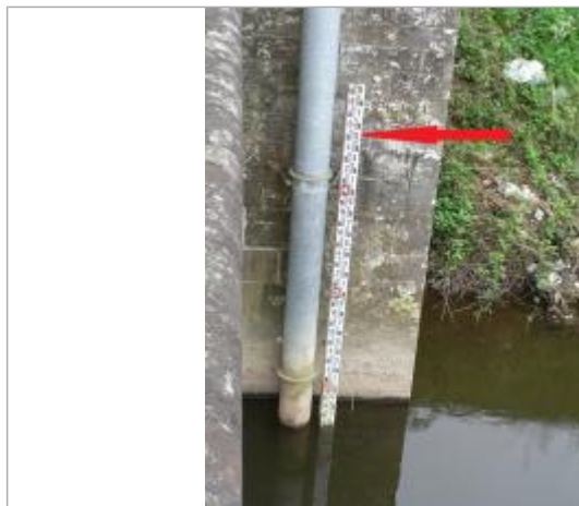
Echelle limnimétrique de l'Aulne à Gouézec Pont-Coblant
