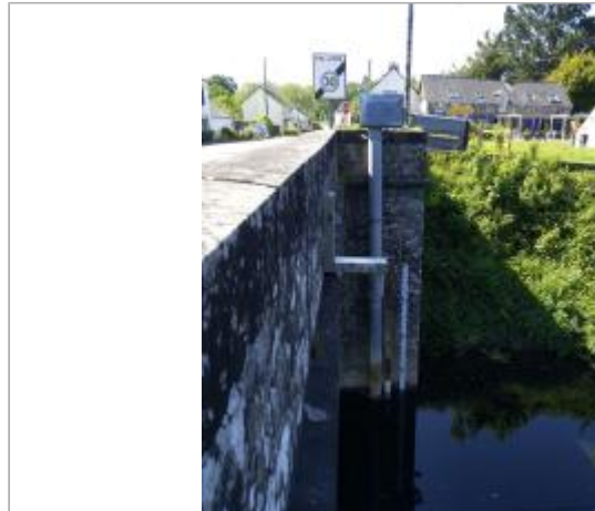
Station limnimétrique de l'Aulne à Gouézec Pont-Coblant
