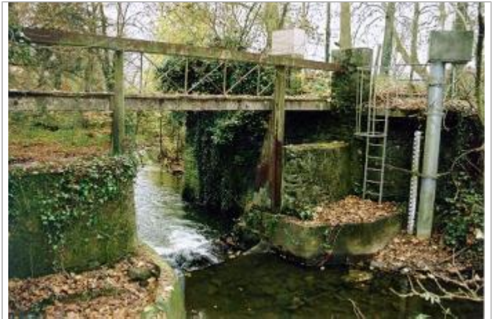
Station limnimétrique de la Valière à l'aval du barrage de la Valière aux Rochers
