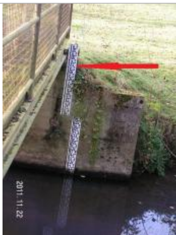
Echelle limnimétrique de la station de la Vilaine à Vitré (Rideux)
