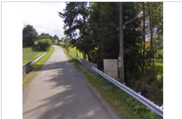
Station limnimétrique de la Valière à Erbrée en 2011
