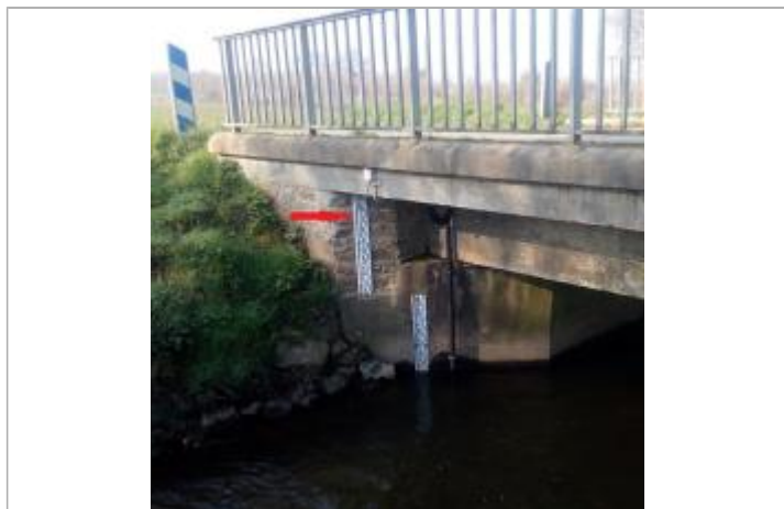
Echelle limnimétrique sous le pont coté Bourgon
