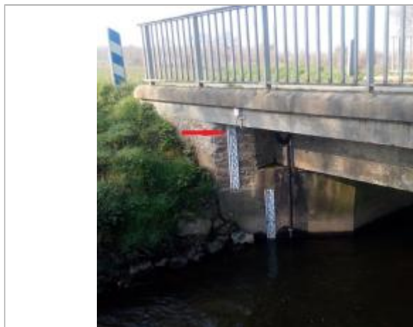
Echelle limnimétrique sous le pont coté Bourgon
