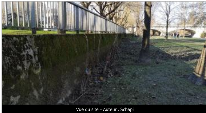
Vue du site - Auteur : Schapi
