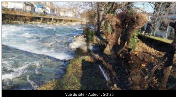
Vue du site - Auteur : Schapi
