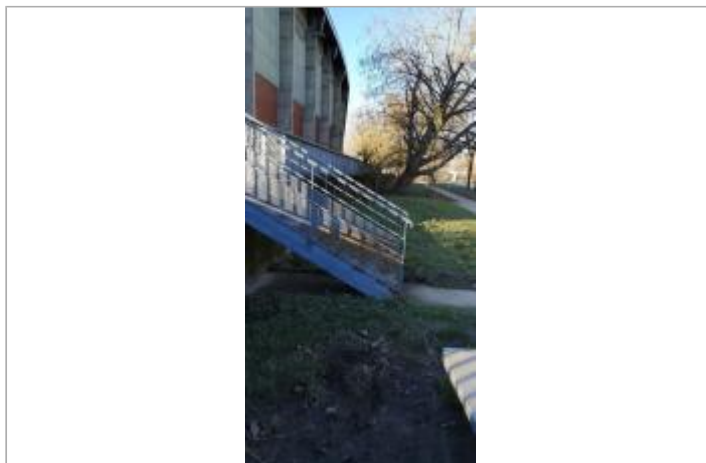
Vue du site - Auteur : Schapi
