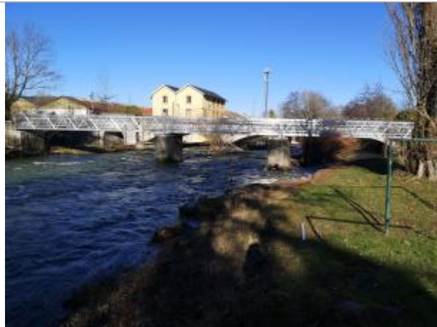
Vue du site - Auteur : Schapi
