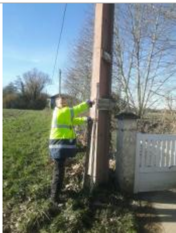
Photo de la laisse - Auteur : Cerema Dter Sud-Ouest
