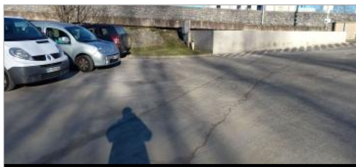
Photo de la laisse - Auteur : Cerema Dter Sud-Ouest
