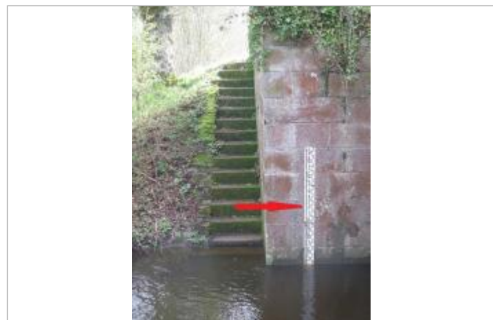
Echelle limnimétrique en amont du pont
