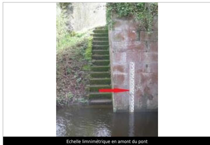
Echelle limnimétrique en amont du pont
