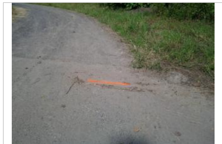
Vue du repère (le trait orange représente la limite de l'inondation) - Auteur : HEA/DDTM 64
