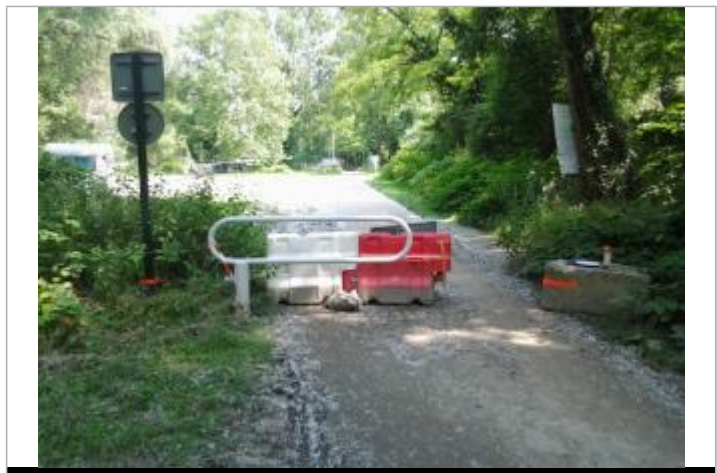
Vue du repère (les traits orange représentent le niveau atteint par les eaux) - Auteur : HEA/DDTM 64
