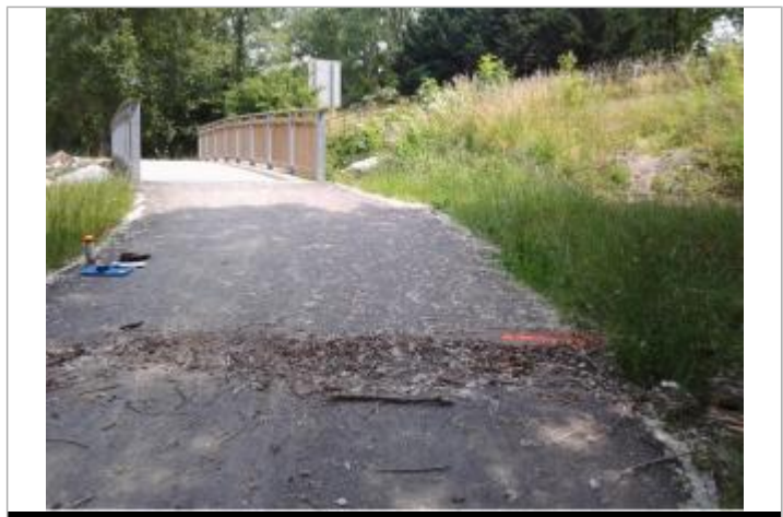
Vue du repère (le trait orange représente la limite de l'inondation) - Auteur : HEA/DDTM 64
