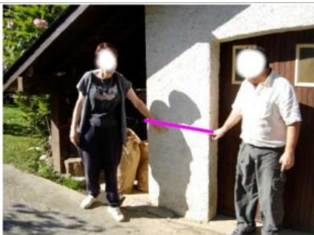
Vue du repère (le trait rose représente le niveau atteint par les eaux) - Auteur : ISL
