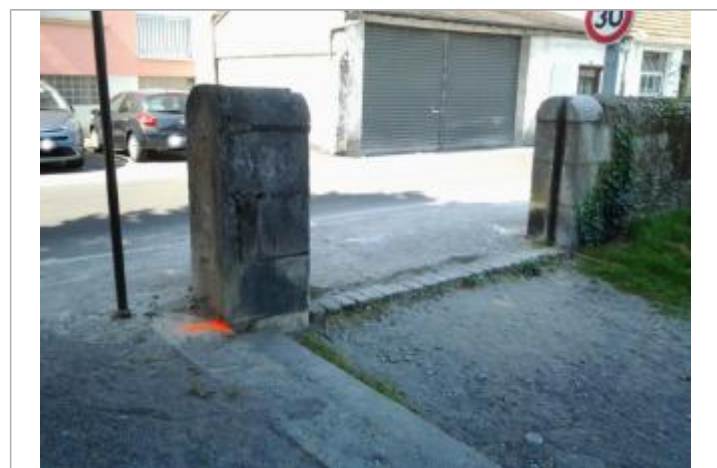
Vue du repère (la peinture orange représente le niveau atteint par les eaux) - Auteur : HEA/DDTM 64
