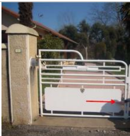
Vue du repère (la flèche rouge représente le niveau atteint par les eaux) - Auteur : HEA
