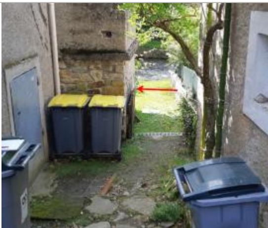
Vue du repère (la flèche rouge représente le niveau atteint par les eaux) - Auteur : HEA
