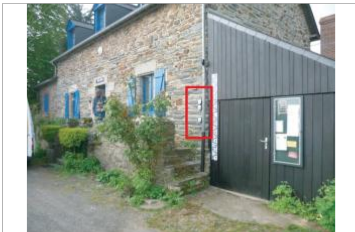
Maison éclusière de Malon
