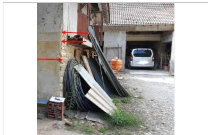
Vue du repère (la flèche rouge du milieu représente le niveau atteint par les eaux) - Auteur : HEA
