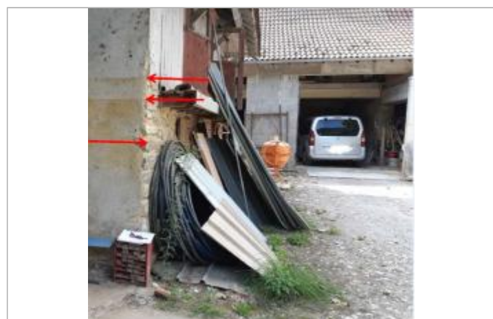
Vue du repère (la flèche rouge du bas représente le niveau atteint par les eaux) - Auteur : HEA
