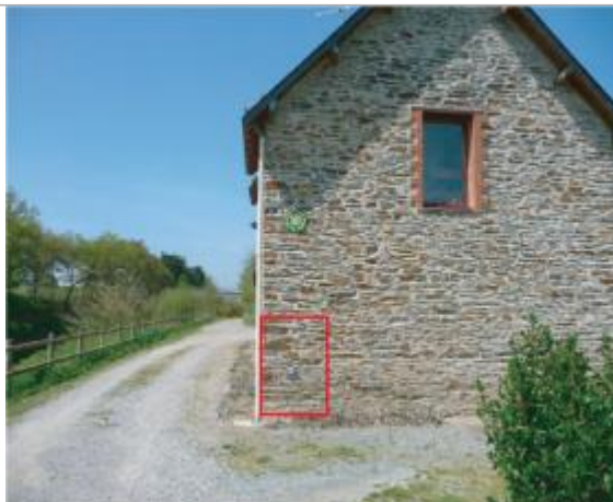
Gîte communal en amont du pont de painfaut
