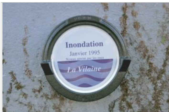
Repère normalisé de la crue de Janvier 1995
