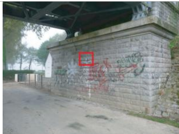
Pont SNCF en aval de l'écluse de Guipry-Messac
