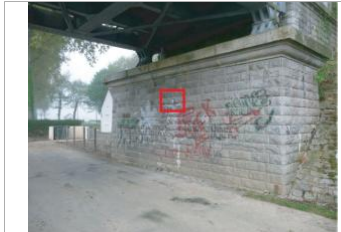
Pont SNCF en aval de l'écluse de Guipry-Messac
