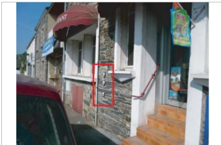
Commerce au 15 quai des Bellantiers
