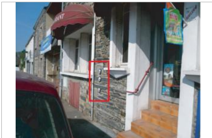
Commerce au 15 quai des Bellantiers
