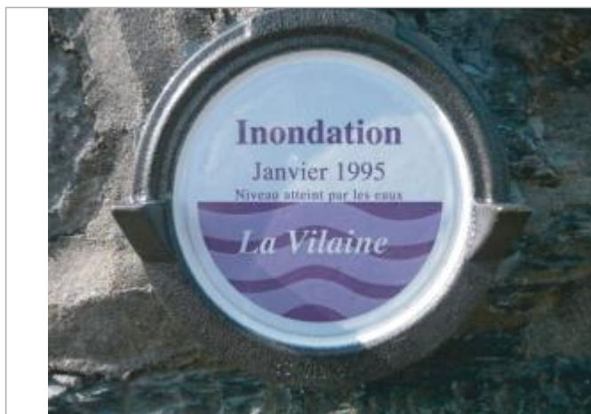
Repère normalisé de la crue de Janvier 1995
