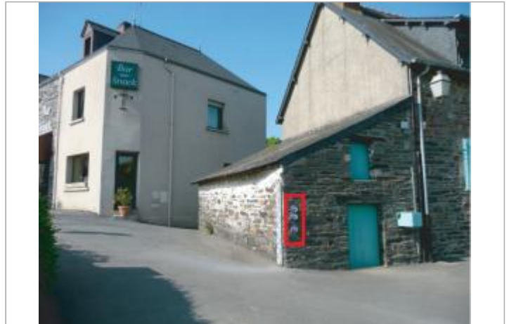
Maison éclusière de Guipry-Messac
