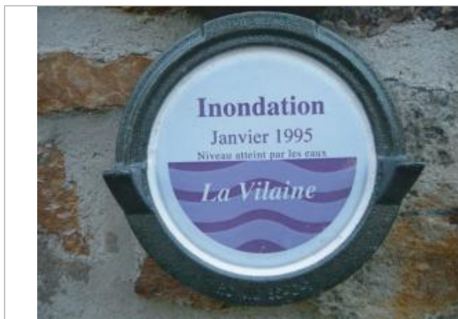
Repère normalisé de la crue de Janvier 1995
