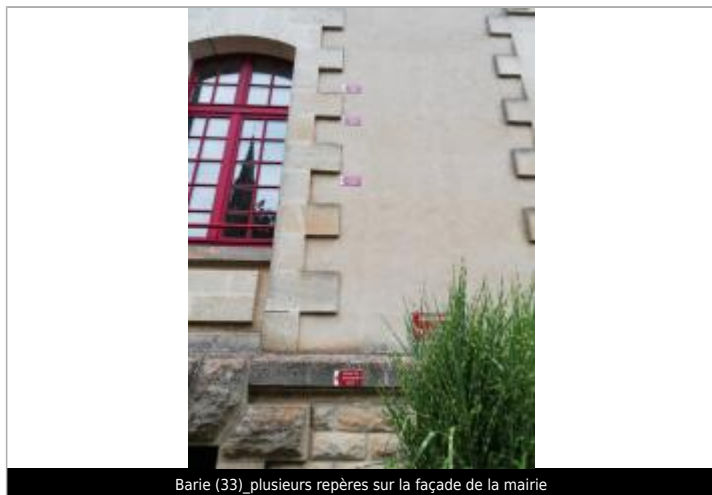
Barie (33)_plusieurs repères sur la façade de la mairie
