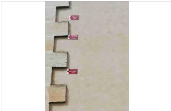
Barie (33)_plusieurs repères sur la façade de la mairie
