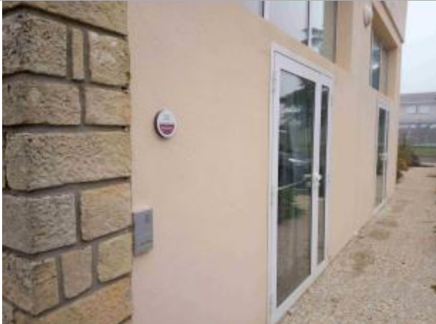
Floudès (33)_repère février 2021 à l'entrée de la salle polyvalente sous la mairie
