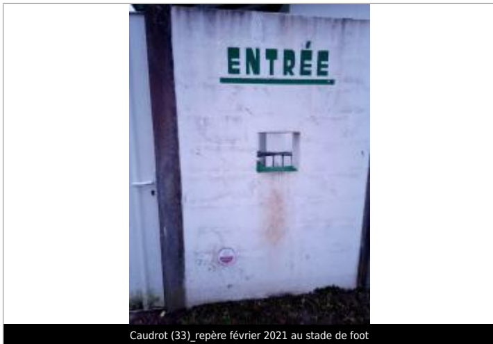
Caudrot (33)_repère février 2021 au stade de foot
