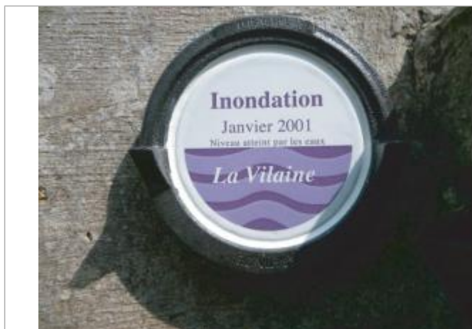
Repère normalisé de la crue de janvier 2001
