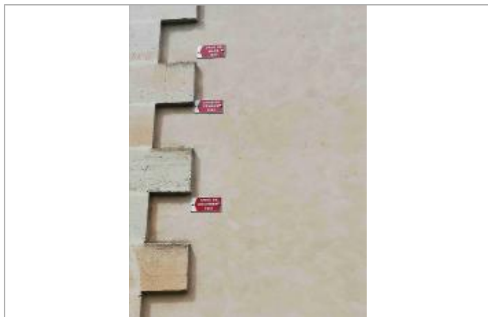
Mairie de Barie (33)_plusieurs repères de crues
