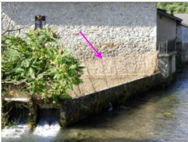
Vue du repère (le trait rose montre les laisses d'inondation les plus hautes) - Auteur : ISL
