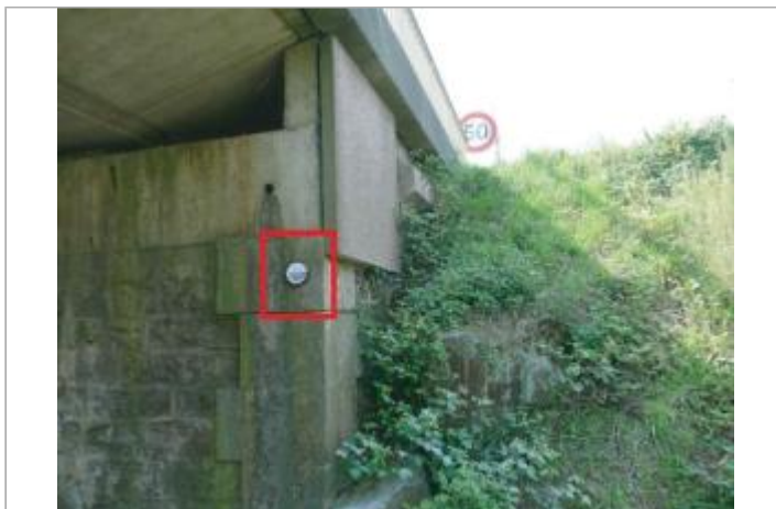
Pile du pont RD42 (Amont), La Bruère
