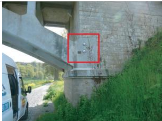
Pile de pont RD84 (amont), La Charrière
