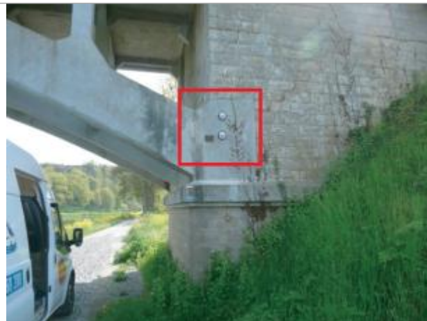
Pile de pont RD84 (amont), La Charrière
