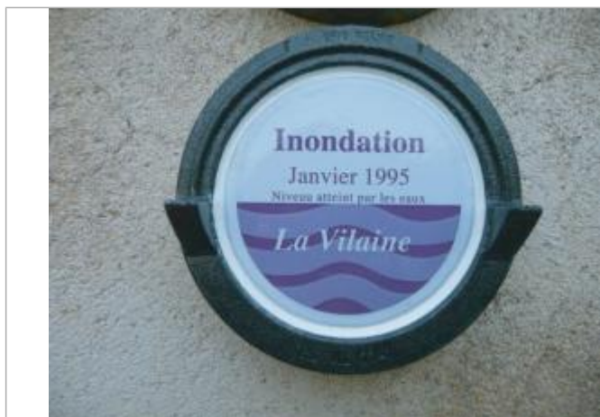
Repère normalisé de la crue de Janvier 1995
