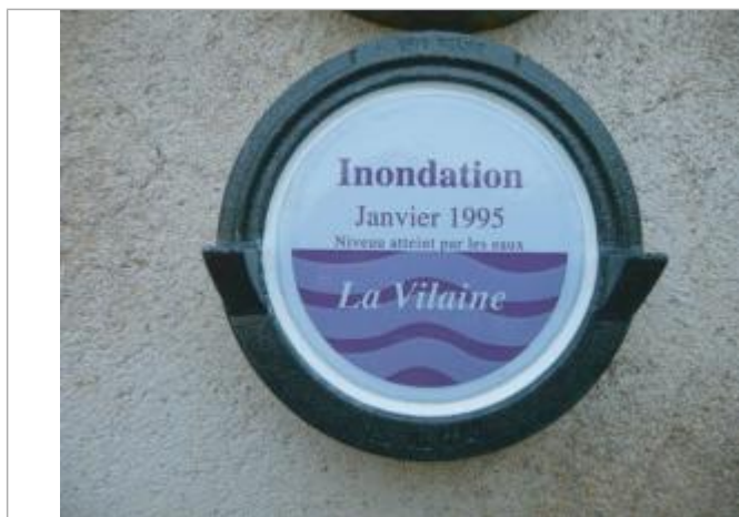
Repère normalisé de la crue de janvier 1995
