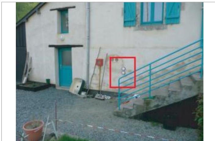
Maison éclusière de la Molière
