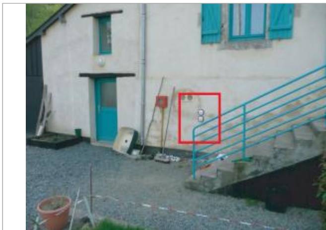
Maison éclusière de la Molière
