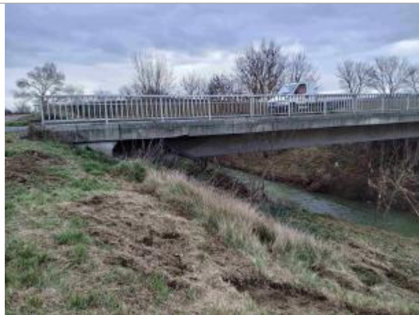
Vu du pont a l'aval rive droite
