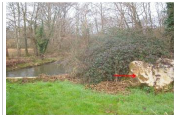
Vue du repère (la flèche rouge représente le niveau atteint par les eaux) - Auteur : HEA
