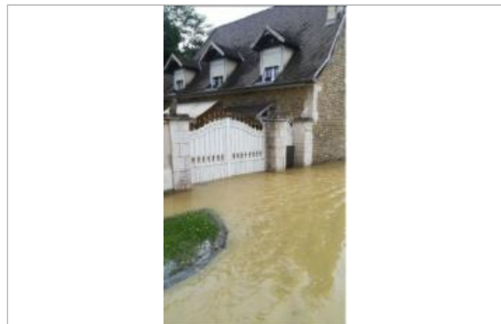
Photo de l'habitation vue depuis la rue durant l'inondation - Auteur : ARTELIA/DDTM 64
