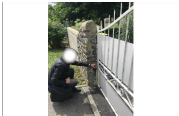
Vue du repère - Auteur : ARTELIA/DDTM 64
