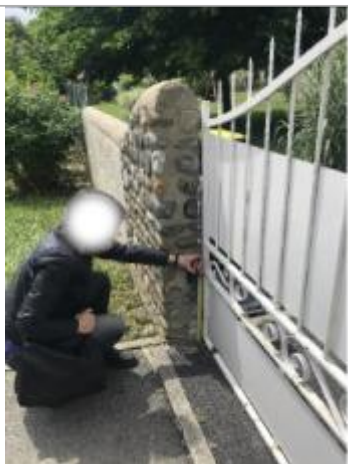
Vue du repère - Auteur : ARTELIA/DDTM 64
