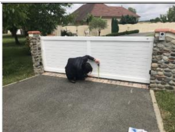
Vue du repère - Auteur : ARTELIA/DDTM 64
