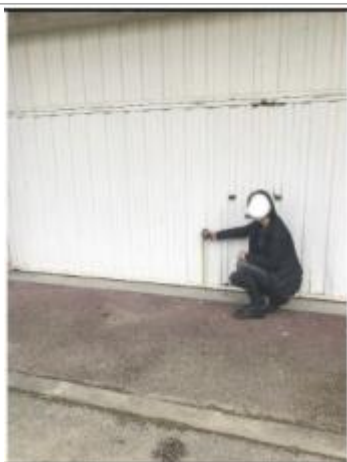
Vue du repère - Auteur : ARTELIA/DDTM 64
